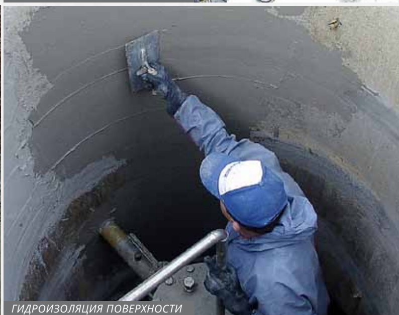
ГЕРМЕТИЗАЦИЯ ТЕКУЩИХ ШВОВ
