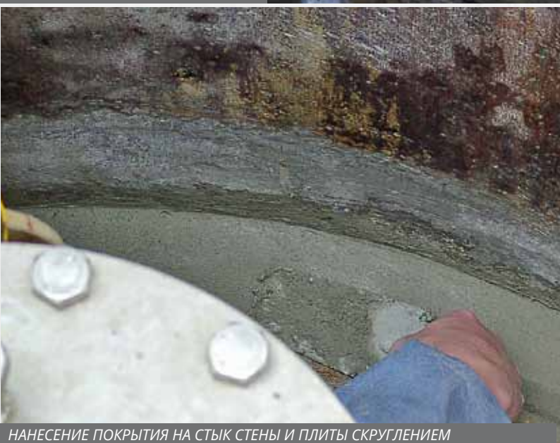
ГЕРМЕТИЗАЦИЯ ТЕКУЩИХ ШВОВ
