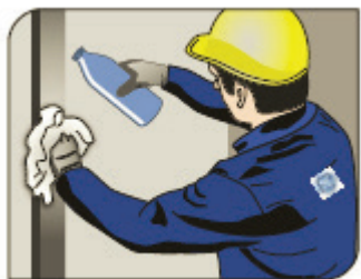
Рис. 10 Очистка и обезжиривание поверхности.
