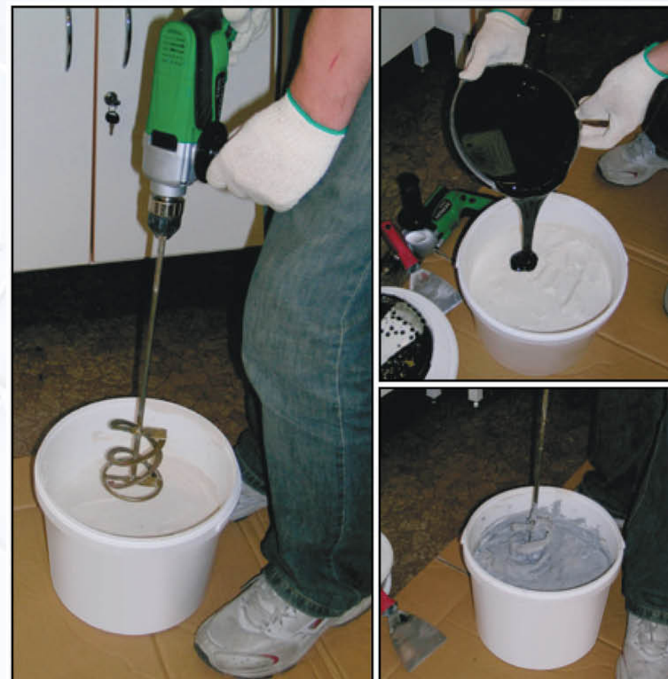
Рис. 3. Перемешивание компонентов герметика
