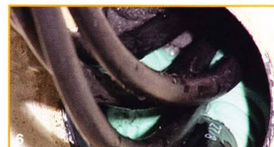
Приподнимите кабели и начинайте заполнение отверстия герметиком STOPAQ® 2100 Aquastop из пистолета вокруг кабелей с использованием гибкого сопла так, чтобы заполнить 100 мм отверстия. Избегать воздушных пробок. Заполнение производить от задней стенки канала фронтальной.
