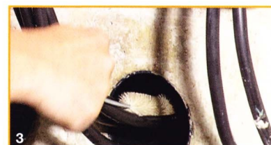
Канальные отверстия очистить с помощью щетки и чистящей салфетки. Очистка воды не обязательна, поскольку STOPAQ® 2100 Aquastop имеет хорошую адгезию к мокрой и сухой поверхности.
