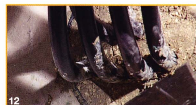
Сглаживания поверхность раствора при помощи шпателя и небольшого количества воды
