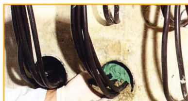
Нанесите раствор в остальные 50 мм глубины канала. Начинать нужно с нижней части между кабелями.
