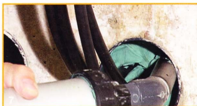
Применить STOPAQ® 2100 Aquastop до 50 мм от передней части канала.
