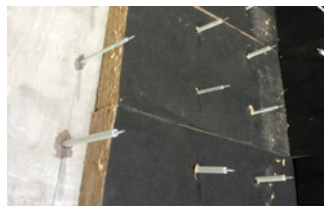
Пример монтажа Schock Isolink
