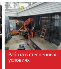
Монтаж крупногабаритного стекла
