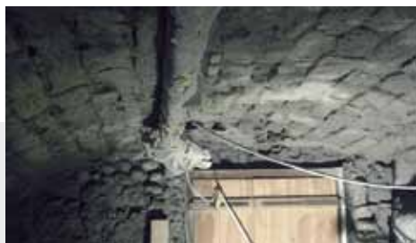
4 Первый слой VANDEX UNI MORTAR 1
