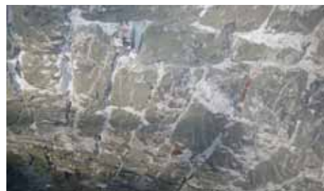
3 Удаление поврежденной штукатурки
