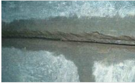
Ремонт течи в стене:
