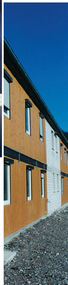
Клеевые соединения и уплотнения, стойкие к атмосферным воздействиям, в модульных строительных конструкциях.
