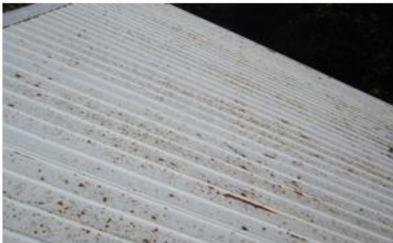
Рисунок 5 Металлическая кровля до покрытия
