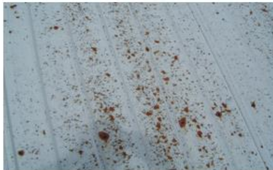
Рисунок 6 Металлическая кровля до покрытия
