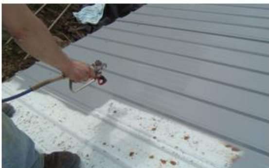
Рисунок 11 Нанесение покрытие на панели
