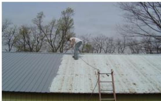
Рисунок 10 Тщательная промывка кровли
