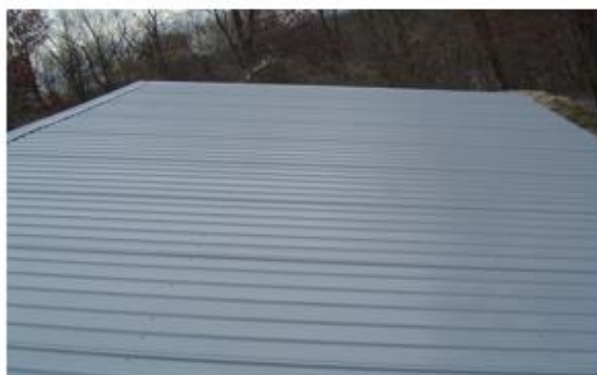
Рисунок 14 Кровля укрыта покрытием GE Enduris
