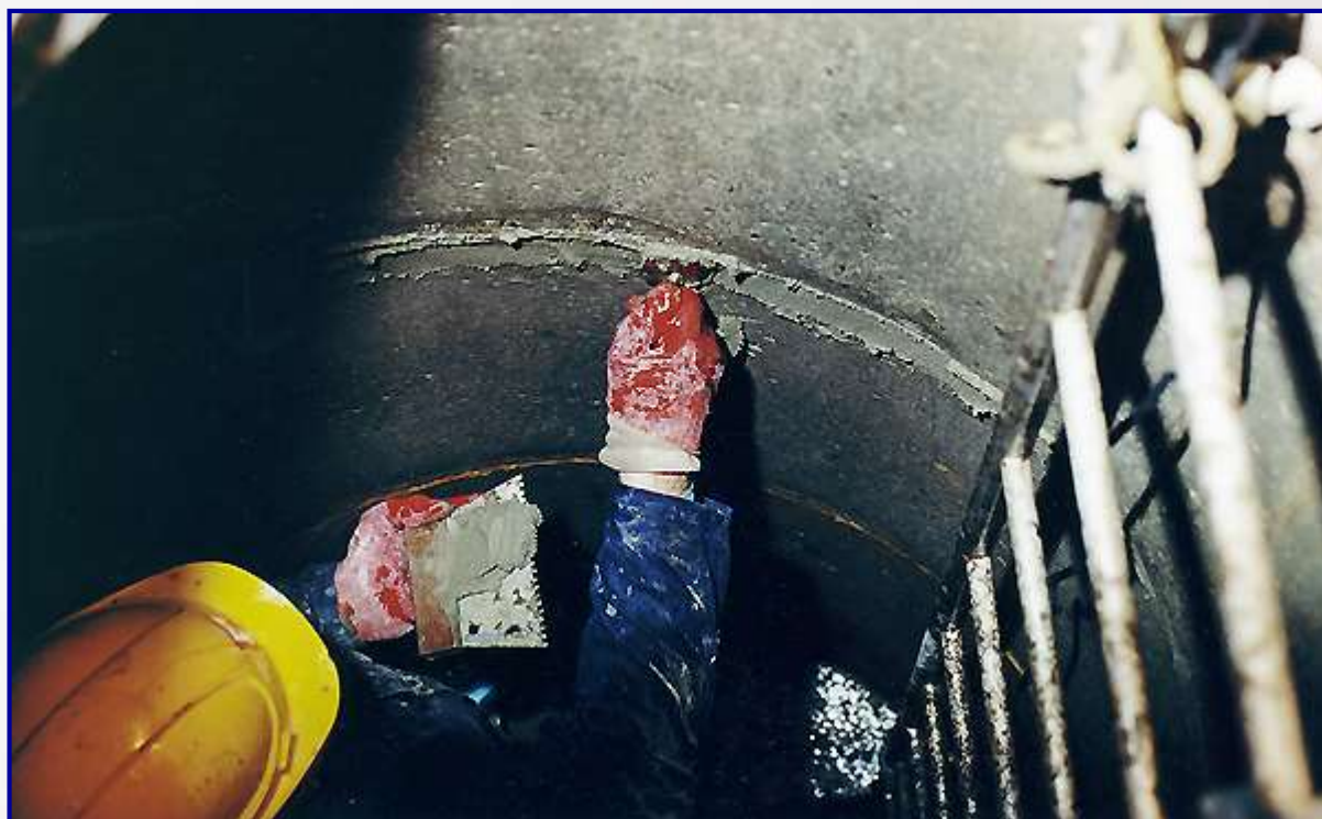
Герметизация протекающих швов с помощью VANDEX RAPID M
