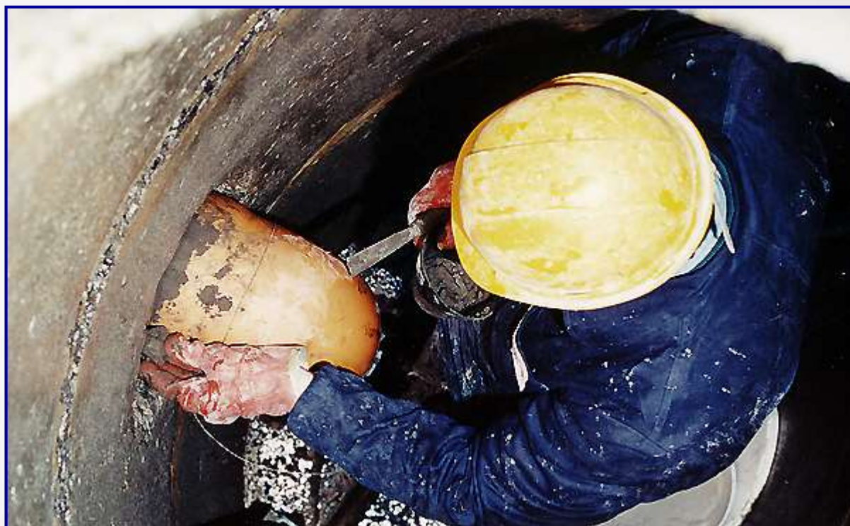
Заделка поврежденных швов и соединений труб
