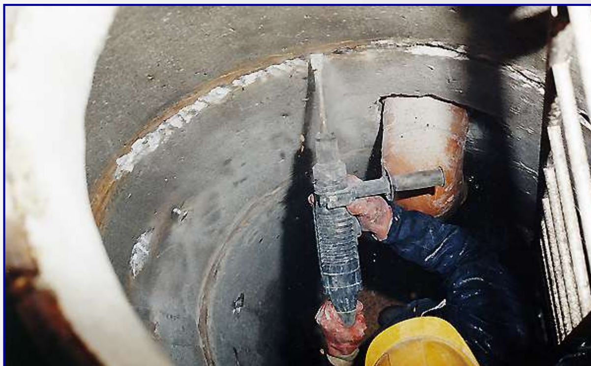
Предварительная обработка трещин и швов
