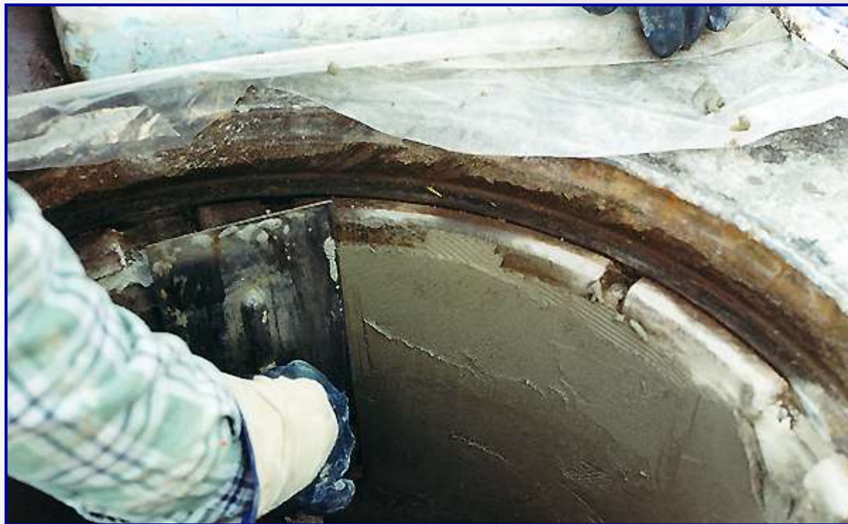
Шпаклевание верхней части люка с помощью VANDEX RAPID S
