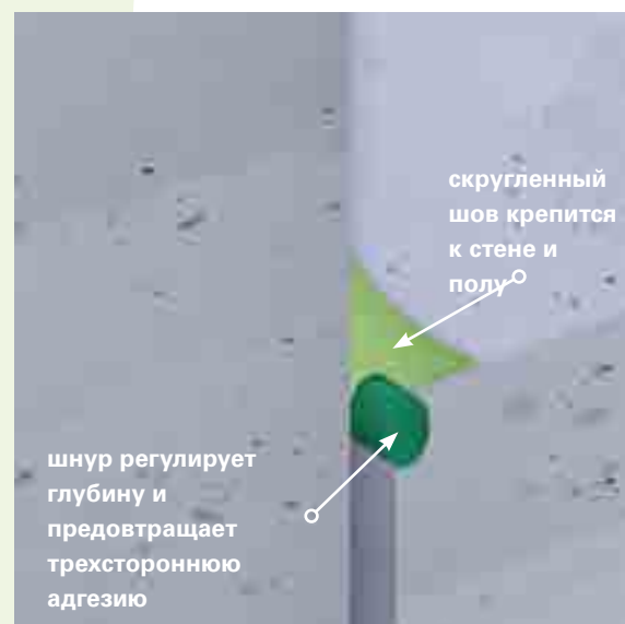
Угловой шов в месте соединения стены и пола
