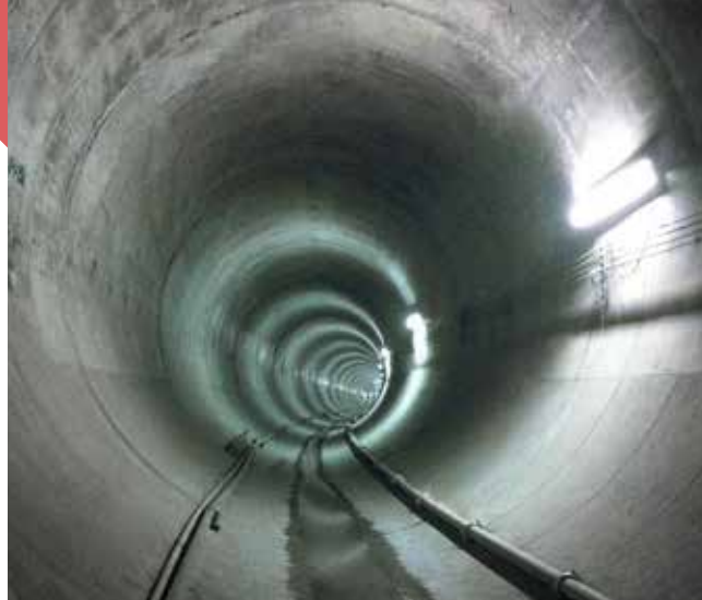
г.Мехико: Тоннель для сточных вод
