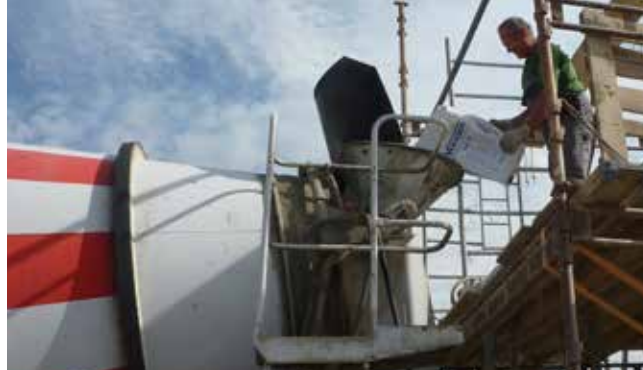
VANDEX AM 10 добавляется в бетономесительную установку
